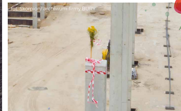
Wiecha w firmie BURY kończąca pierwszy etap budowy magazynu wysokiego składowania.
